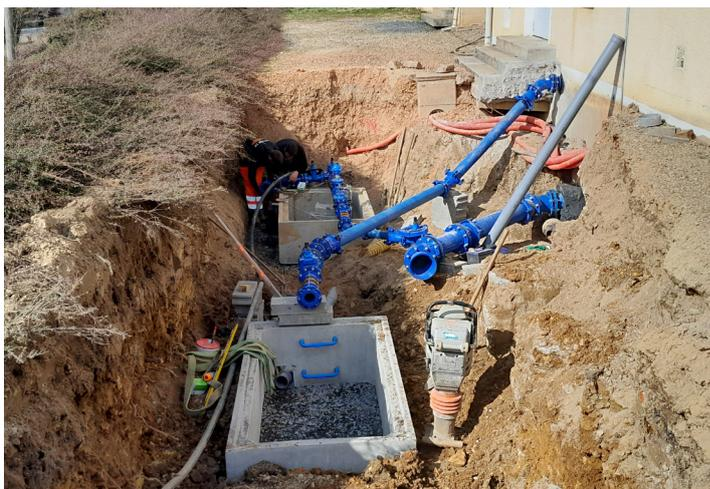
Regard de régulation hydraulique à l'arrivée de l'interconnexion à la station de Baugy
