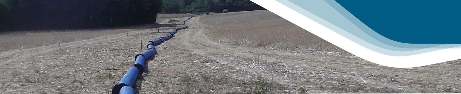
Un essai de mise en route de l'interconnexion a été effectué en juillet 2022 et a permis de confirmer la potentialité hydraulique de l'interconnexion d'environ 20 m<sup>3</sup>/h.
