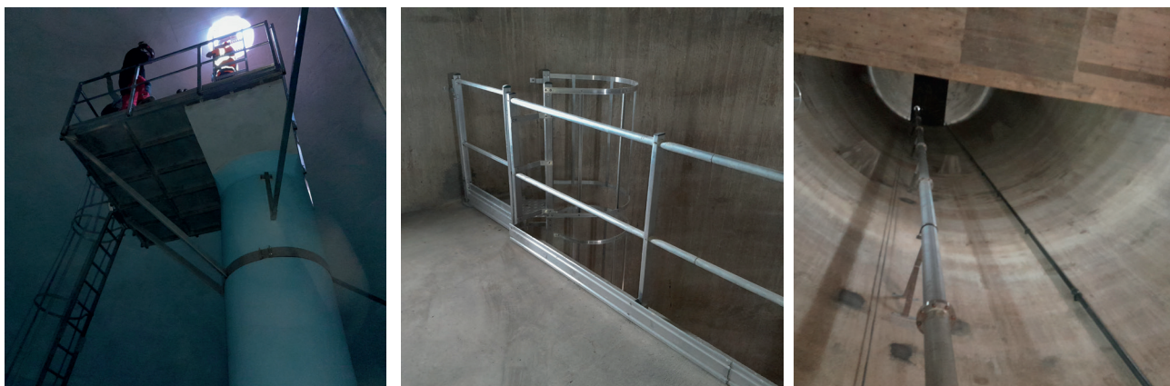
Réhabilitation du réservoir du Fay (SME de la Seillette)
