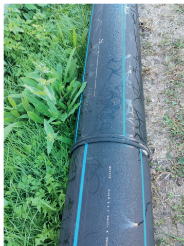
Soudure au miroir
