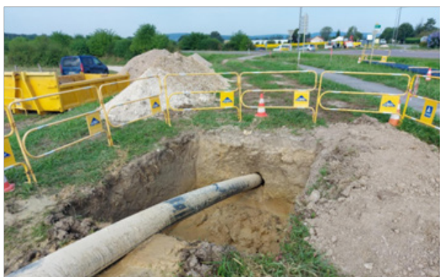
Forage dirigé sous Rond-Point de la RD978
