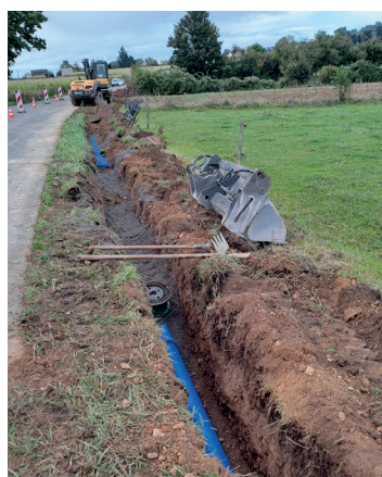
Pose de la canalisation
