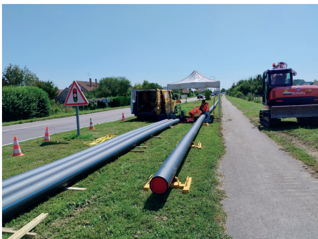
Soudure des canalisations en PEHD
