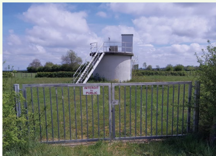
Station de traitement de Frangy-en-Bresse Filtres à charbon actif (SME de la Seillette)
