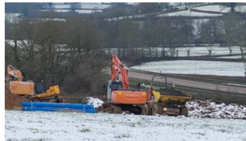
Sainte Cécile travaux de renouvellement liés aux travaux d'aménagement de la RCEA
