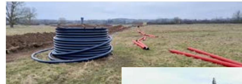
Pose de la conduite d'arrivée de l'interconnexion au puits P2 de St Martin du Lac
