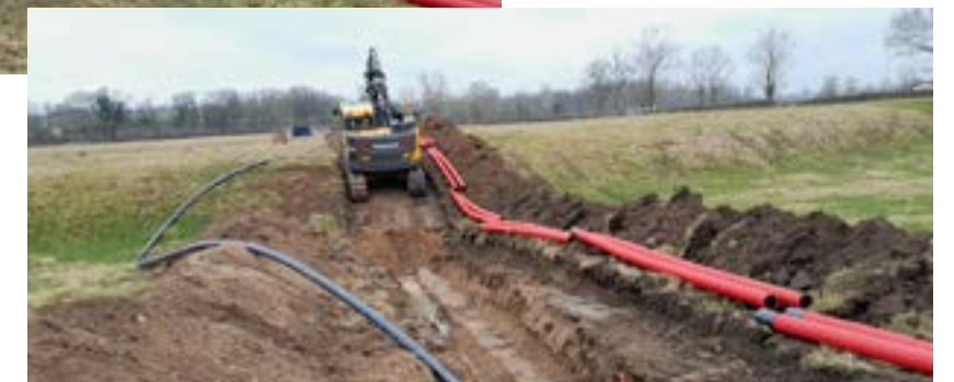
Pose de la conduite d'arrivée de l'interconnexion au puits P2 de St Martin du Lac
