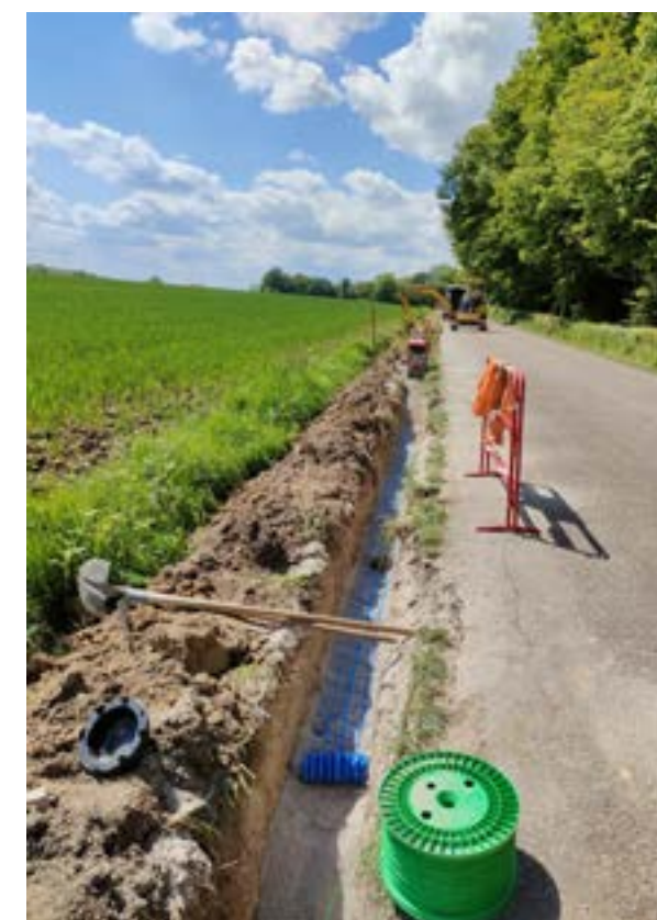
Travaux de renouvellement de conduite d'eau potable
