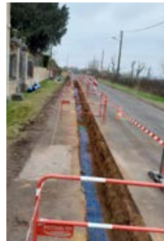
Pose de la conduite d'interconnexion au Sud de Marcigny
